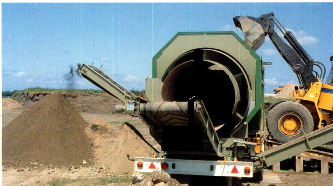
Figur 5. Bakterier, næringssalte og skumgummi bliver blandet med den PCP-forurenet jord i en jordblandingsmaskine.
