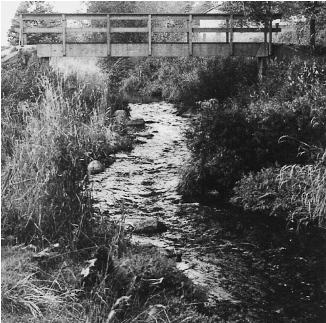
El relleno y la esclusa modificada.
