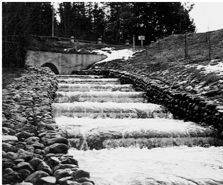
La escala de estanques en el arroyo de Græse vista mirando aguas arriba en dirección al puente.
