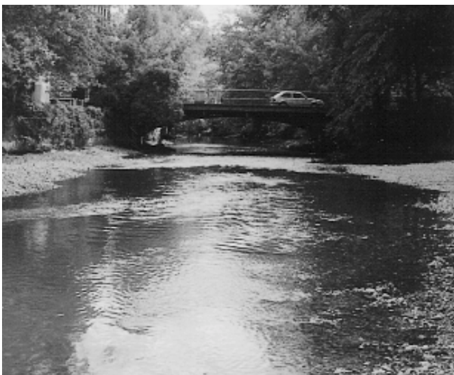
El banco de desove visto mirando aguas abajo.
