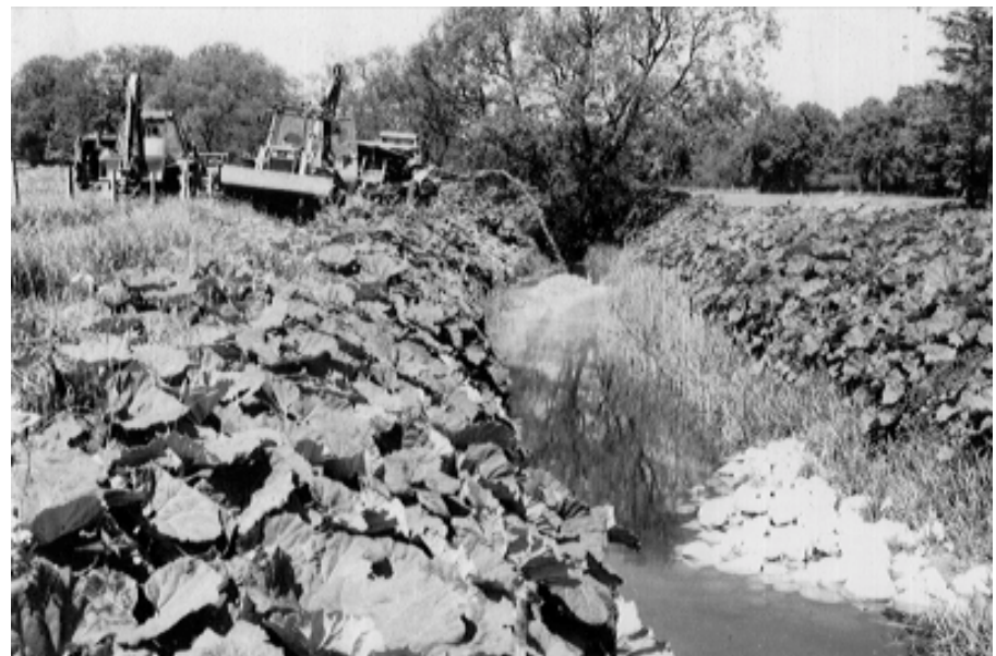
Colocación de piedras y cascajos de desove en el arroyo de Køge.
