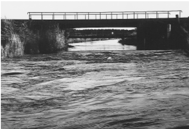
Figura 4.10. La obstrucción es sustituida por un relleno.
