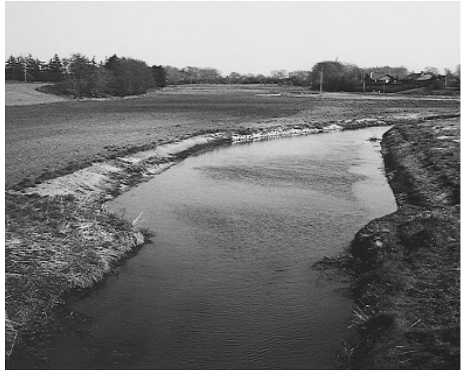
Figura 4.8. Los recolectores de arena reducen el transporte de arena suspendida dentro del arroyo.
