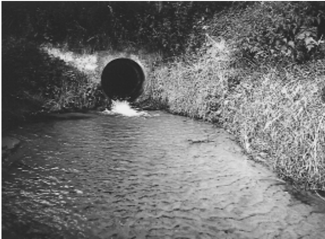
Figura 4.14. Nivelado de represas en la boca de una tubería. En aquellos casos en que la boca de una tubería, p.ej. debajo de un camino, se encuentra a un nivel superior al del agua (izq.) se puede establecer un relleno pequeño o bajar la tubería al nivel de fondo de la corriente (der.).
