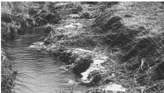
Figura 4.3. Un perfil transversal doble asegura una profundidad y una corriente de agua adecuadas en períodos secos.
