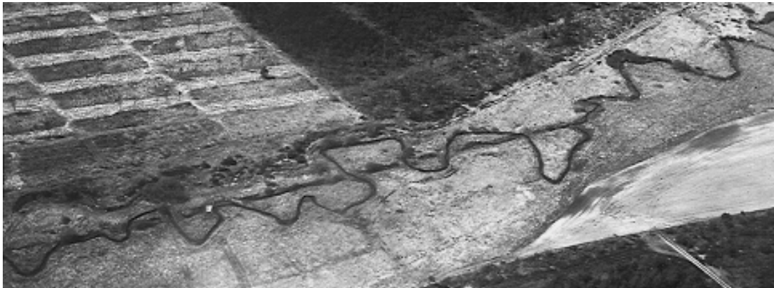
Figura 4.2. El restablecimiento de meandros en tramos de arroyos puede servir varios propósitos, por lo cual este método está incluido en todos los tres tipos de proyectos de restauración/rehabilitación. Bajo el tipo 1, el restablecimiento de meandros crea hábitats más variados dentro del arroyo, entre otros motivos debido a la alternación consecuente entre mucha y poca profundidad y entre corrientes fuertes y débiles. Además, la corriente de los arroyos meandriformes impide que los cascajos y piedras se cubran de arena.
