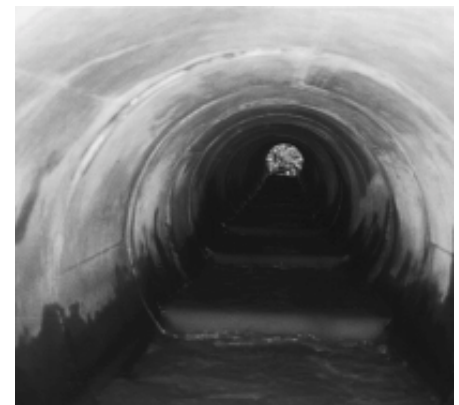
Figura 4.13. Áreas de retención de la corriente en tuberías debajo de un camino. Para asegurarles a los peces el libre paso por las tuberías, se puede elevar el nivel del agua e insertar áreas de retención de la corriente.
