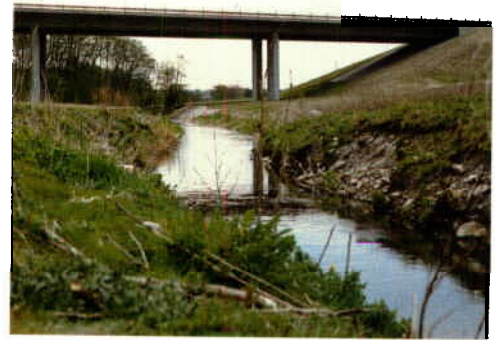
Figur 5. Faunapassager kan have forskellige udformninger. Her er vist et vandløb under et vej-anlæg med både strømmende vand og bevoksede bræmmer.
