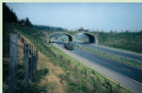
Faunaoverføring ved Jyske Ås/E 45 i Vendsyssel.
