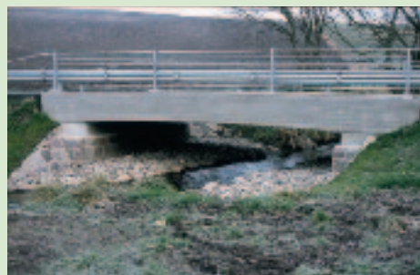
Faunaunderføring i nyrestaureret bro ved Kousted Å.
