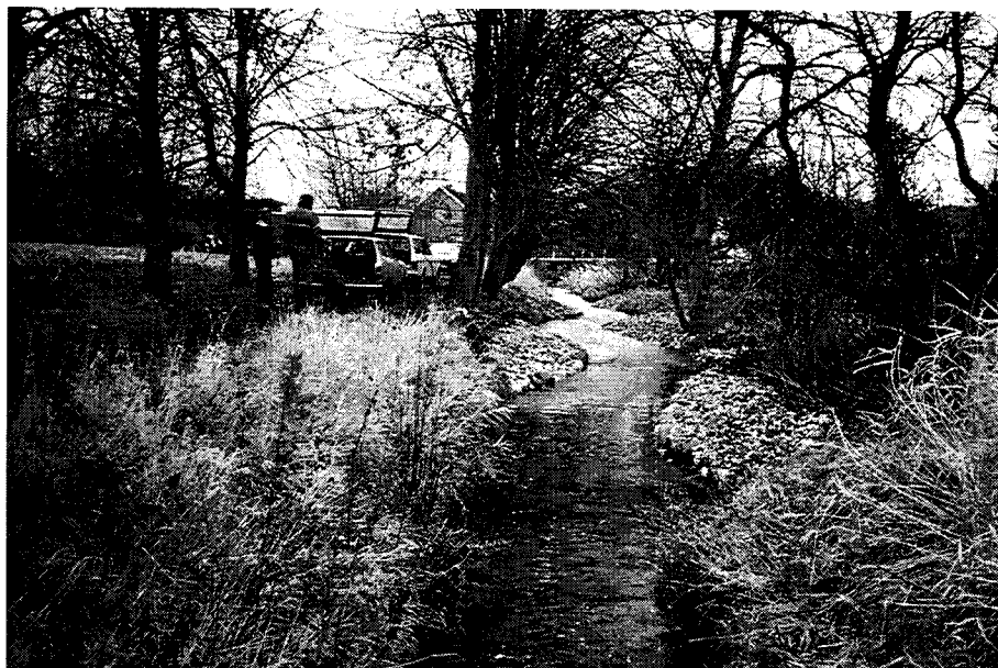
Figur 4.7. Strømkoncentratorer sikrer at der skabes strøm nok til at holde grusbunden fri for sand.
