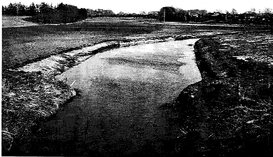
Figur 4.8. Sandfang reducerer sandtransporten i vandløbet.
