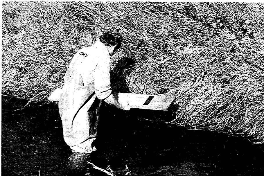
Figur 4.6. Kunstige fiskeskjul var en af de oprindelige genopretningsmetoder i vandløbsloven. I dag er metoden sjælden.
