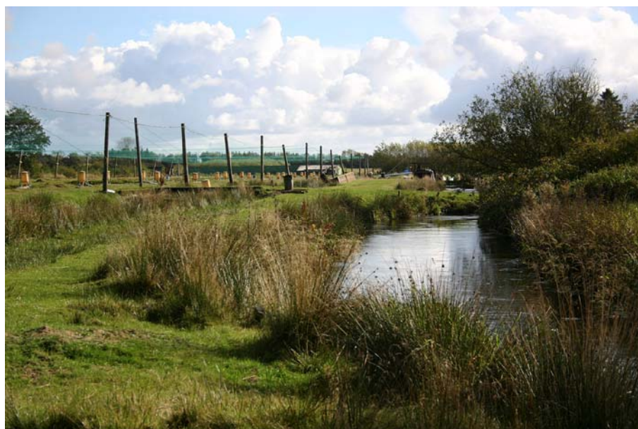
Figur 2.5 Nørre Aagaard Dambrug ved Sunds Nørreå. Dambruget ligger som det øverste ud af 3 dambrug i afløbet fra Sunds sø.
