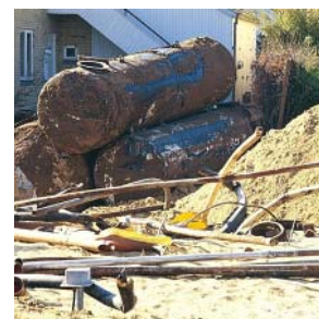
Nedgravede olie- og benzintanke er ofte årsag til jordforurening.
