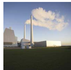
Avedøreværket. Kraftværket producerer ca. 30 % af elforbruget på Sjælland. Foto: DONG Energy.
