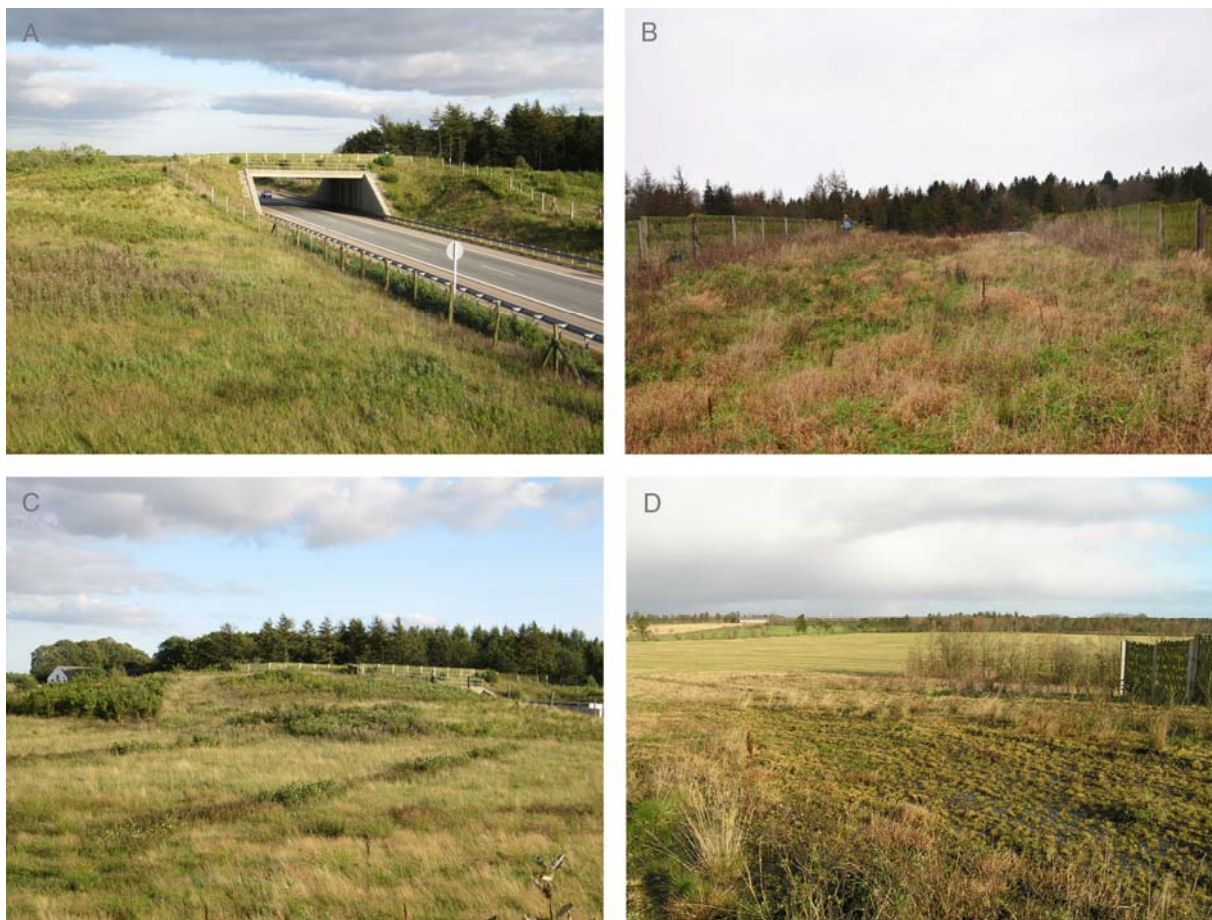
Figur 10. A: Faunabroen set fra vest. B: Udsigten op over passagen mod syd. C: Passagen set fra nordvest. D: Det åbne omgivende landskab mod nordøst. Der mangler ledelinjer mellem passagen og skovområderne mod nord.
