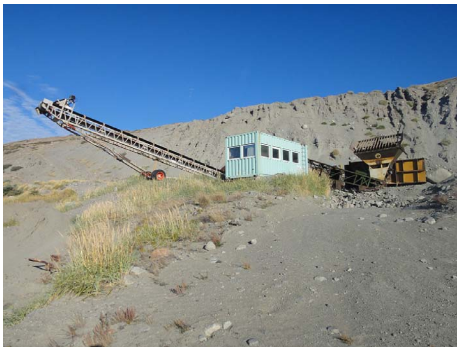
Figur 13. Knuse- og sigteanlæg ved Kangerlussuaq. Moræne materiale, som knuses og sigtes, bliver taget i bakken bag anlæget. Efter knusning kan materialet anvendes som stabillag på veje m.m.
